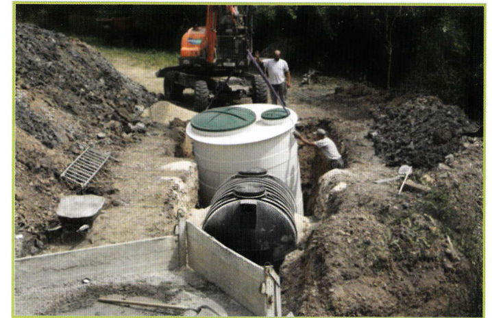
Photo prise lors de la pose des cuves.
