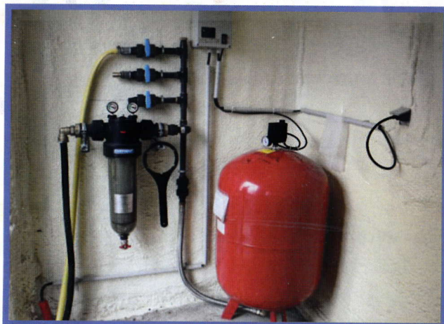
La dernière étape de raccordement terminée.
