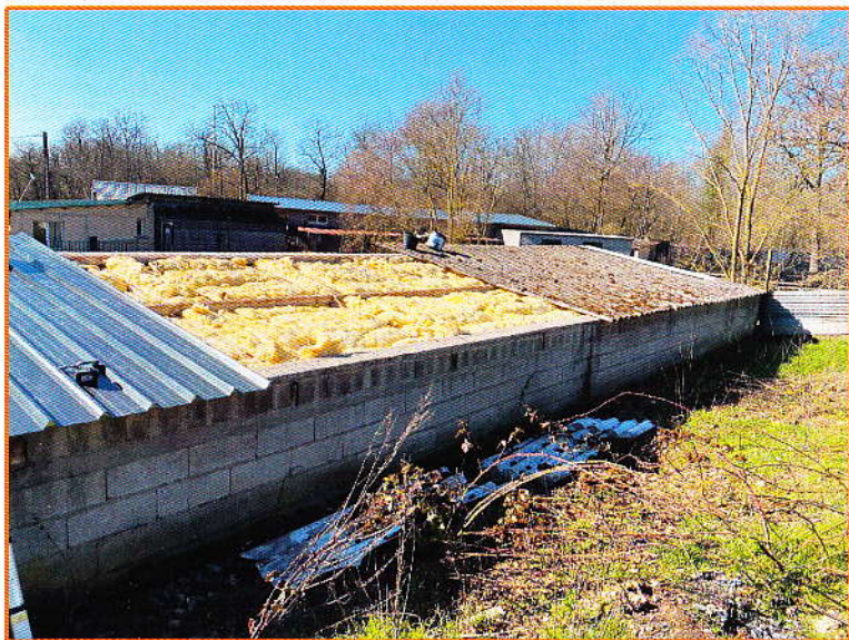
Photo prise lors du remplacement de la toiture
